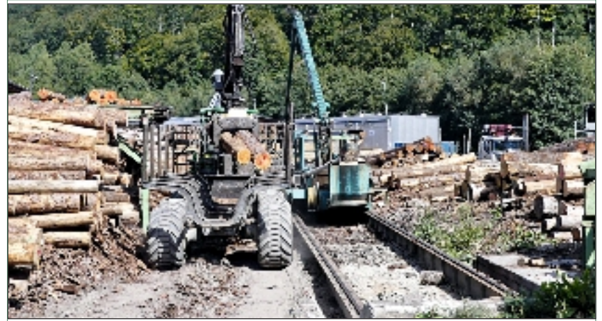
Nach der Inbetriebnahme der neuen Anlage wird der Rundholzplatz im Winter 2019 zurückgebaut und verkauft. Das alte Gattersägewerk wird nach Beendigung des Probetriebs im Frühjahr/Sommer 2020 ebenfalls abgebaut und verkauft.
