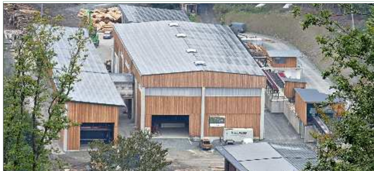
Übersicht über die neuen Produktionsanlagen bei Hegener-Hachmann: Rechts unten am Bildrand angeschnitten die Sägehalle mit der bislang noch in Betrieb befindlichen Gatterlinie von 2007, rechts die Stammaufgabe direkt vom LKW, der Rundholz-Bearbeitungsstrang mit Wurzelreduzierer, Entrinder, Metalldetektor und Stammvermessung verläuft parallel zur Sägehalle (Mitte). Der Rundholzeingang zur Blockbandsäge hinten links. Rechts hinten Abwurfboxen für Rundholz und in der Mitte hinter der Sägehalle überdachte Lagerboxen für Hackschnitzel und Sägespäne. Gebäude links mit Sortierwerk (hinterer Teil) und Abstapelung mit Paketierung (vorderer Teil). Foto: Hegener-Hachmann
