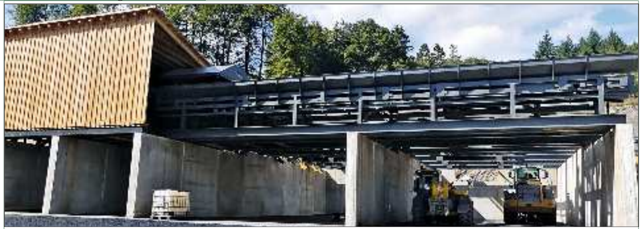
Die Rundholzaufgabe erfolgt direkt und unsortiert vom LKW. Für Rinde und Hackschnitzel werden keine Fördereinrichtungen benötigt: Vom Wurzelreduzierer und vom Entrinder fällt das Material direkt in die darunter liegenden Fahrboxen. Über eine hier noch nicht angebrachte Kippwanne können zwei Rinden-Sortimente getrennt werden.
