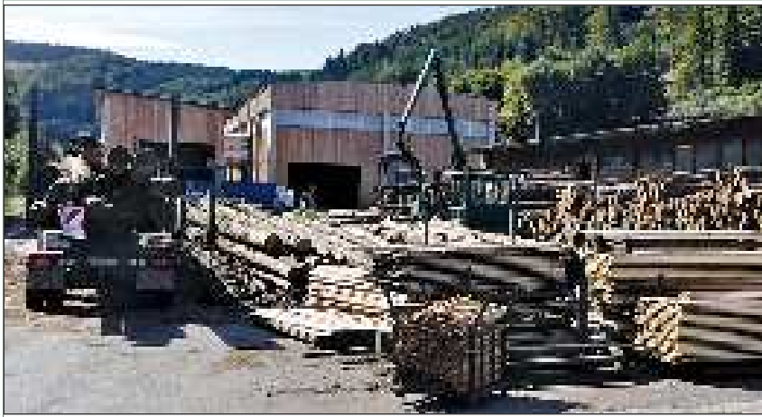
Das Sägewerk Hegener-Hachmann in Schmallenberg: Sägehalle mit 2007 installierter Gatterlinie (rechts) und Rundholzplatz. Im Hintergrund: rechts die neue Sägehalle und links das Stapelwerk Fotos: J. Härer (10)
